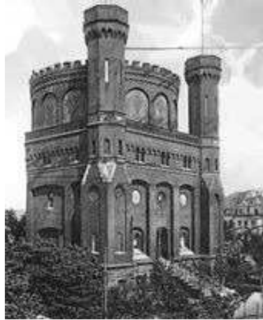
Ansicht in den 1920er Jahren
