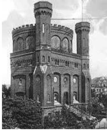
Ansicht in den 1920er Jahren
